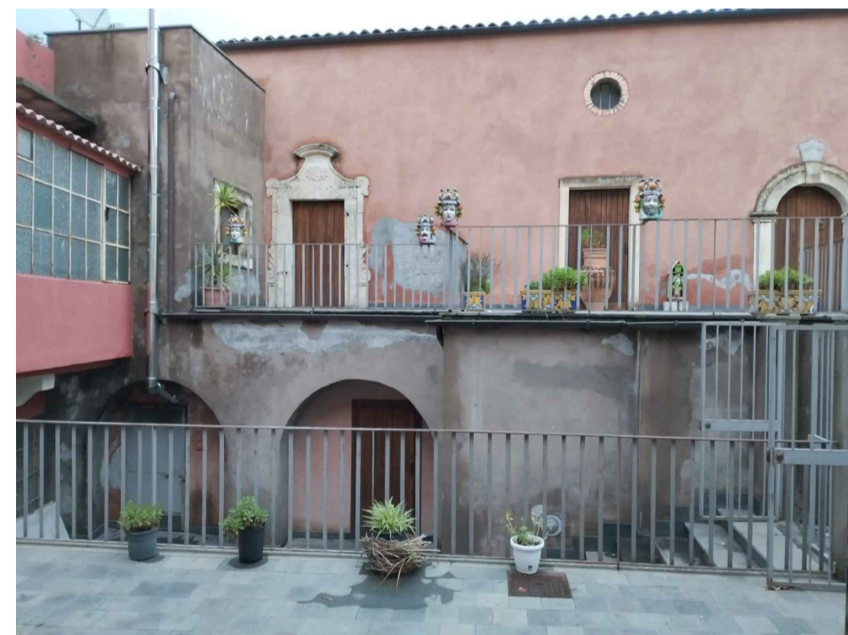
Vista del prospetto lato ingresso
