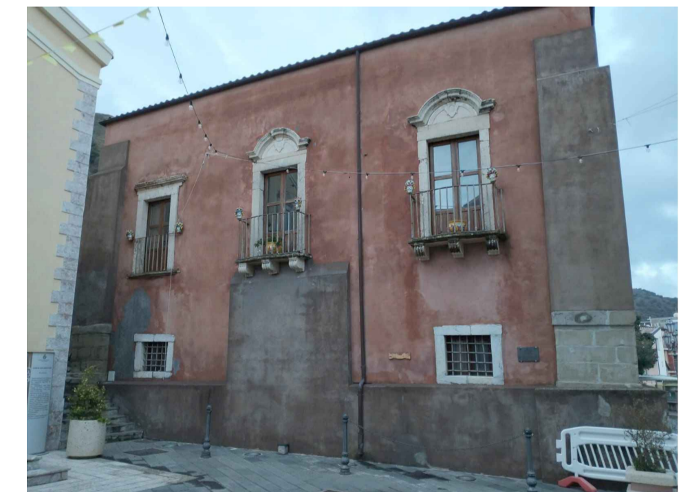
Vista del prospetto lato chiesa
