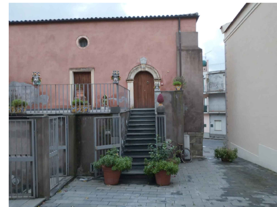
Vista del prospetto lato ingresso
