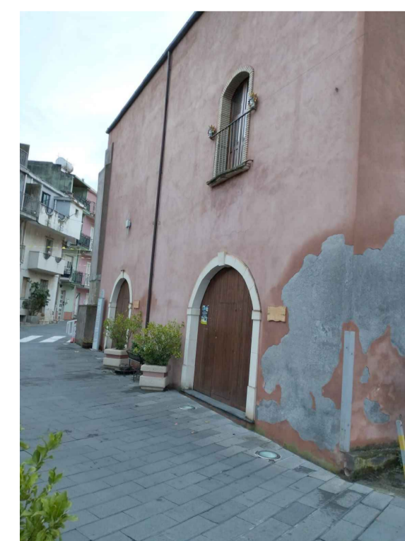
Vista del prospetto lato strada
