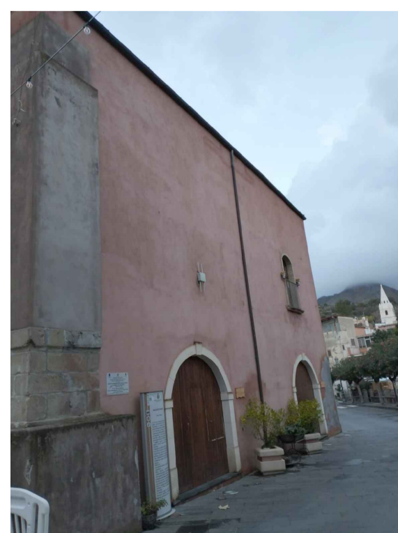
Vista del prospetto lato strada
